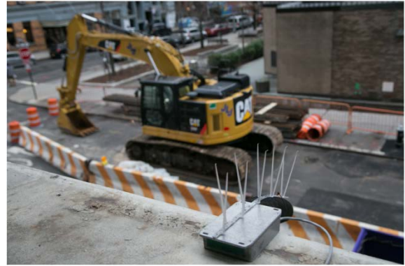
Εικόνα 38 - Μονάδα ακουστικής ανίχνευσης που αναπτύσσεται σε δρόμο της Νέας Υόρκης
