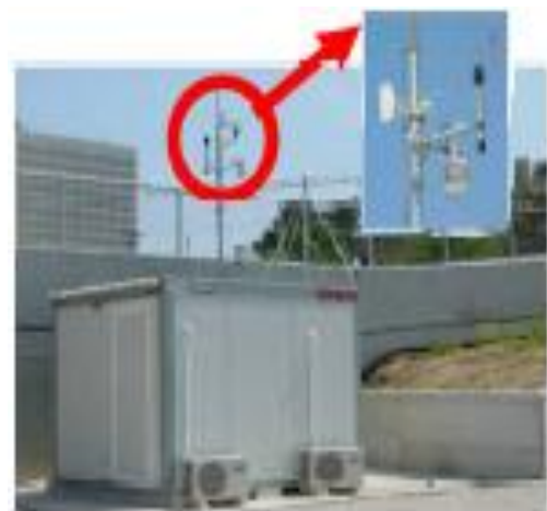
Εικόνα 16. Ειδική στέγαση των σταθμών
