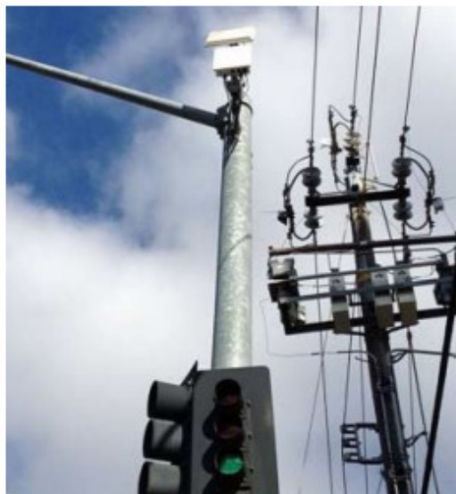
Εικόνα 1: Αισθητήρας για τη μείωση της συμφόρησης στους δρόμους
